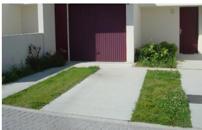
Bande de roulement béton
